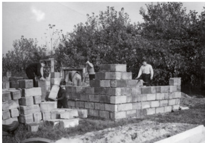
Uczniowie Liceum Ogólnokształcącego przy budowie Pawilonu nr 1
