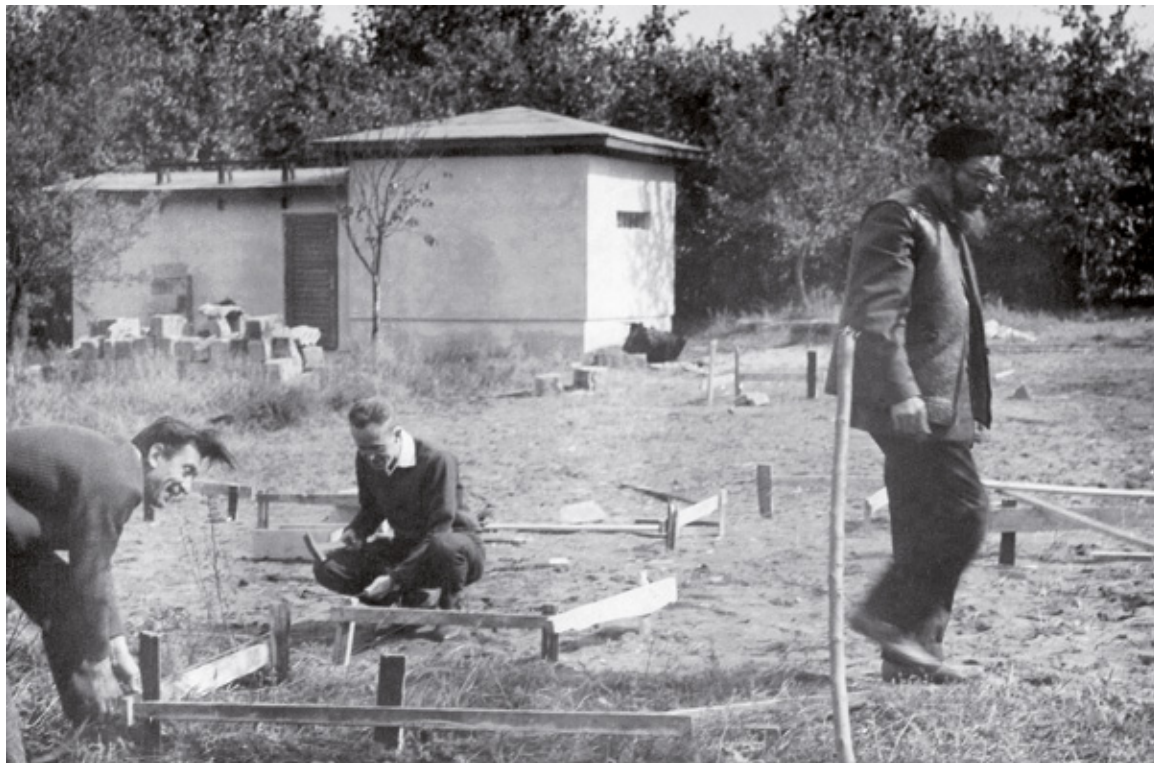
Wyznaczanie fundamentów Pawilonu nr 2, 1963
