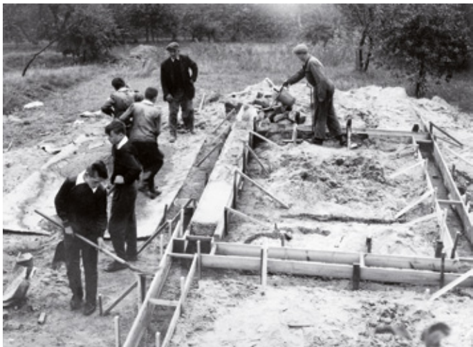
Uczniowie Szkoły Podstawowej nr 1 przy budowie Pawilonu nr 1
