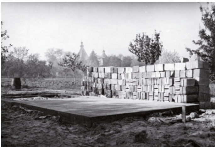
Zakończony etap budowy fundamentów Pawilonu nr 1
